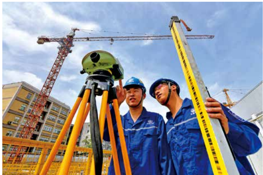
技术人员顶着烈日对香积寺下穿隧道进行测绘作业
