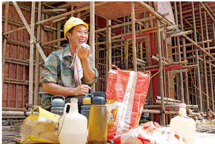
建筑工人在冒着高温切割完钢筋后抽空休息片刻
