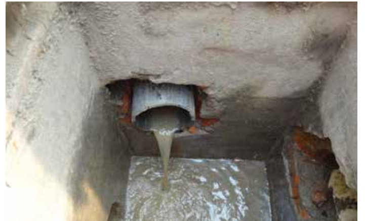
小河路695号对面的管道口
