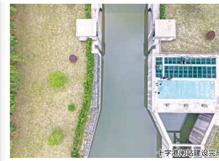
十字港泵站建设完成
