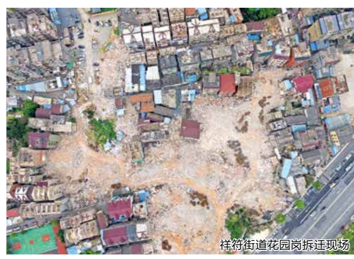
祥符街道花园岗拆迁现场
