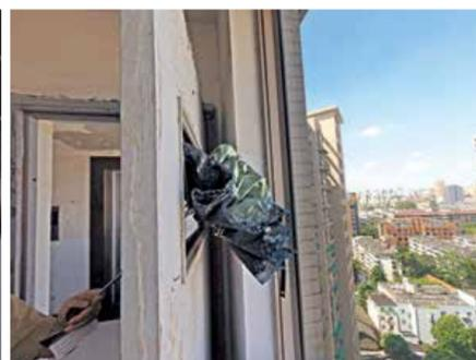
防火门窗玻璃破损,无法起到隔火隔烟作用
