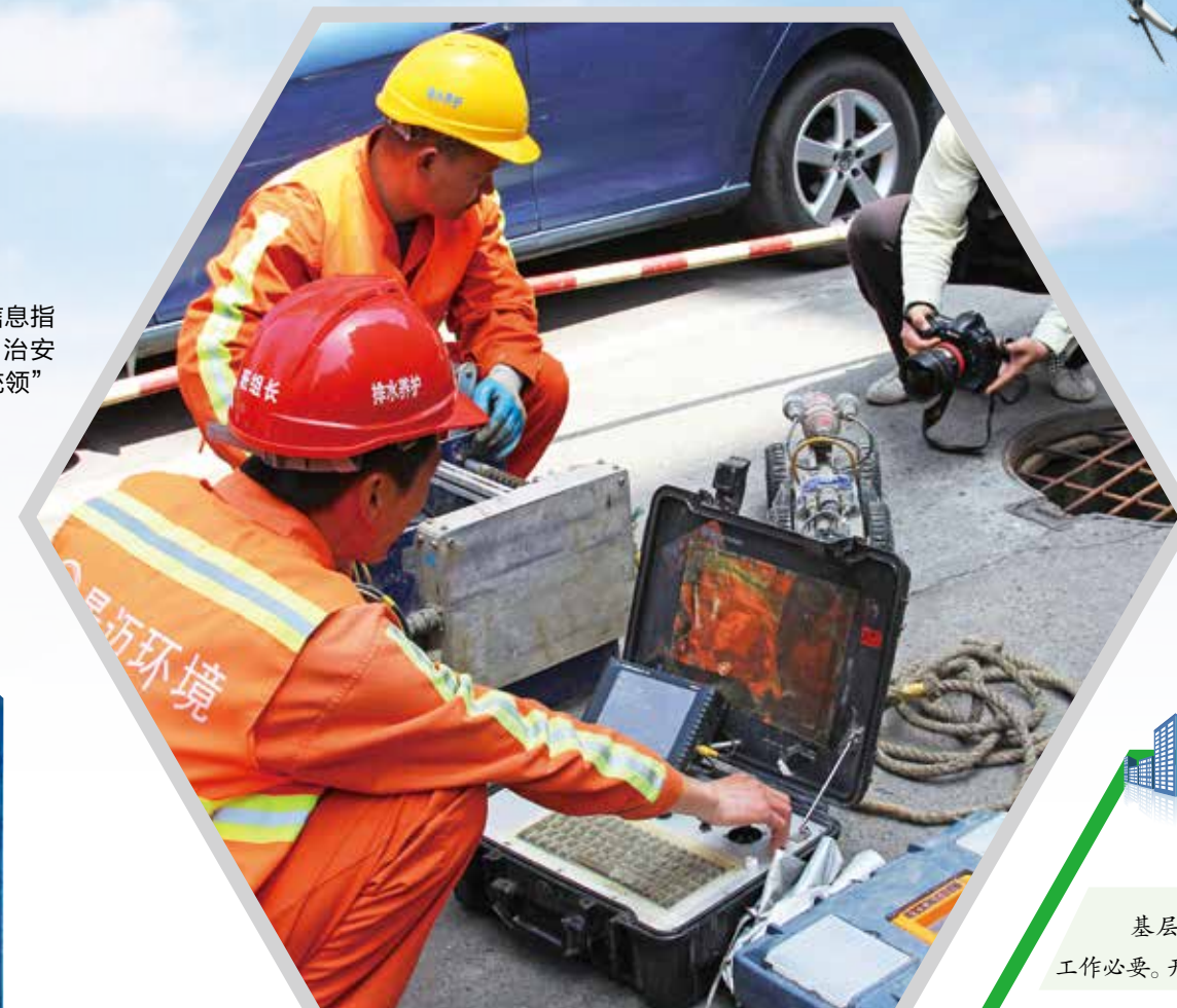
聘请16名“机器人”网格员开展地下“毛细血管”体检,摸清辖区地下管网分布,绘制雨水、污水管网图,并提出养护或者整改建议。
