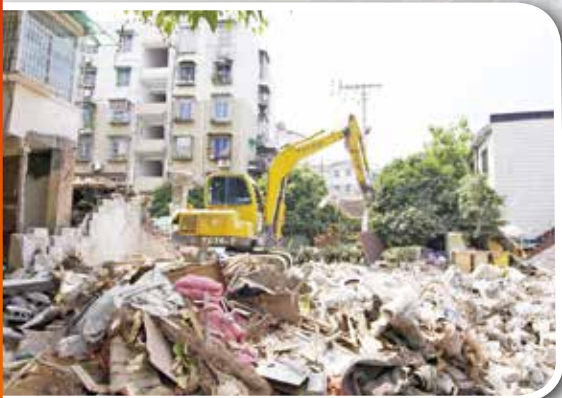
董家新村拆迁现场
