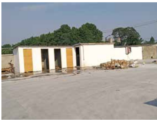
私自建造的卫生间建筑
