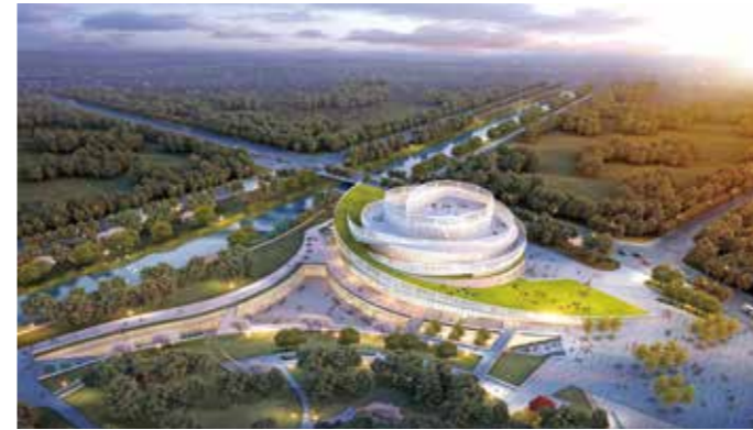
运河中央公园(运河大剧院)： 位于西塘河与十字港河交汇处，总用地面积约166.9亩，其中包括一个1200座的通用剧院，一个400座的多功能小剧院，还有国际运河馆、高科技体验馆、文创展示中心等。
