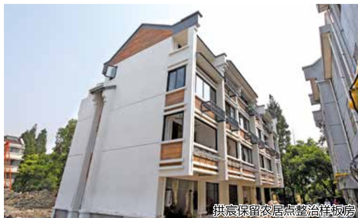
拱宸保留农居点整治样板房
