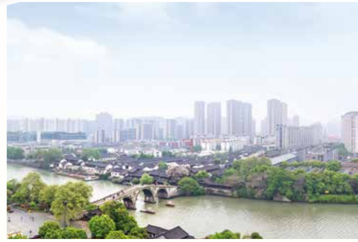
桥西历史街区远景
