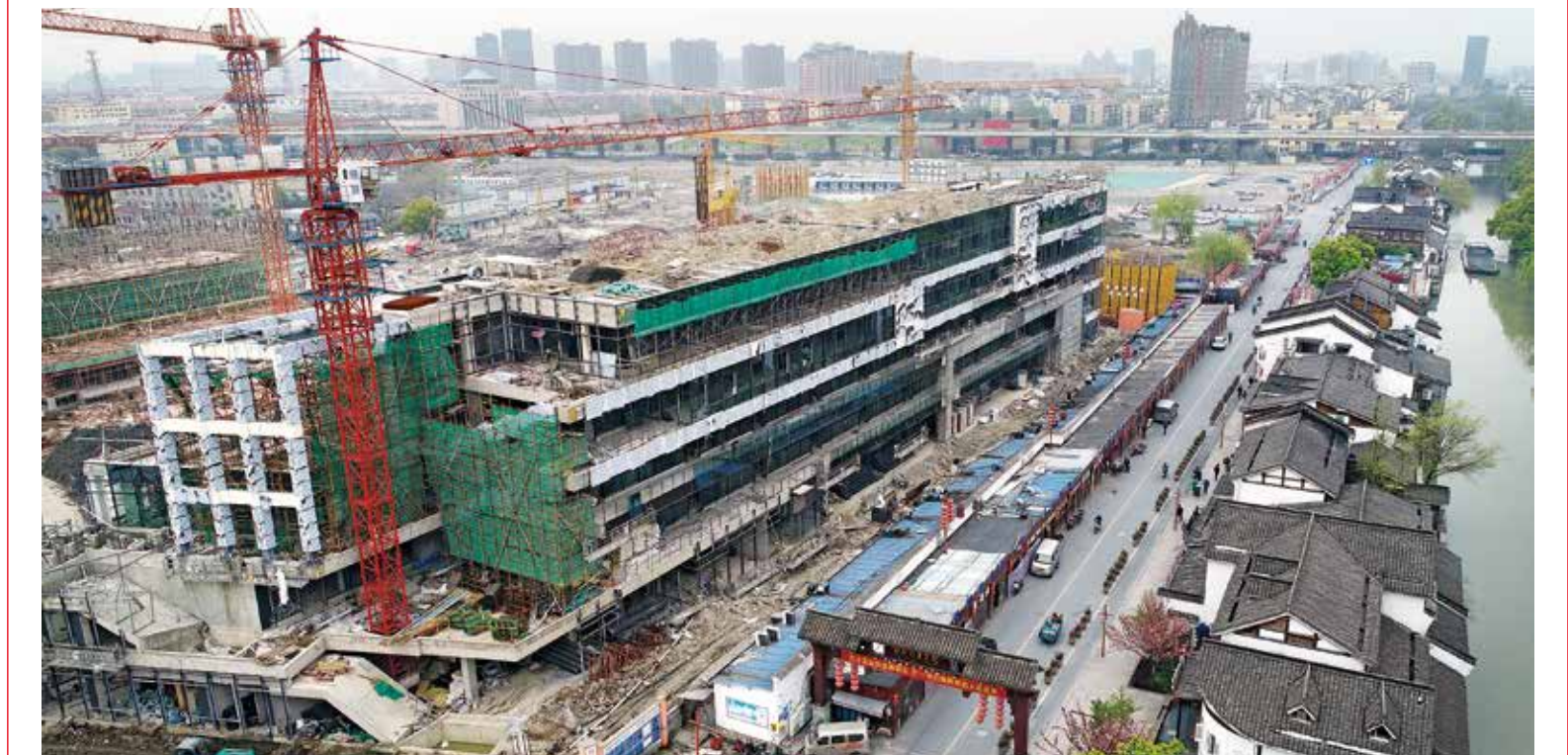
胜利河国字号美食街西牌坊北侧,胜利河旅游综合体项目正在进行玻璃幕墙安装,计划7月竣工。该项目总用地面积7000余平方米,总建筑面积约2万平方米,由一幢5层的商业楼宇和地下2层组成。按照我区公共项目建设专项行动计划安排,该项目将于今年投用,打造一个集餐饮、休闲、娱乐、购物等功能为一体的旅游综合体,与街区式的胜利河美食街交相辉映。
