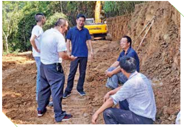
拱墅挂职干部,来凤县委常委、副县长林林(右三)检查旧州镇小河口公路项目建设情况
