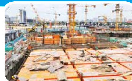
石塘安置房建设工地
