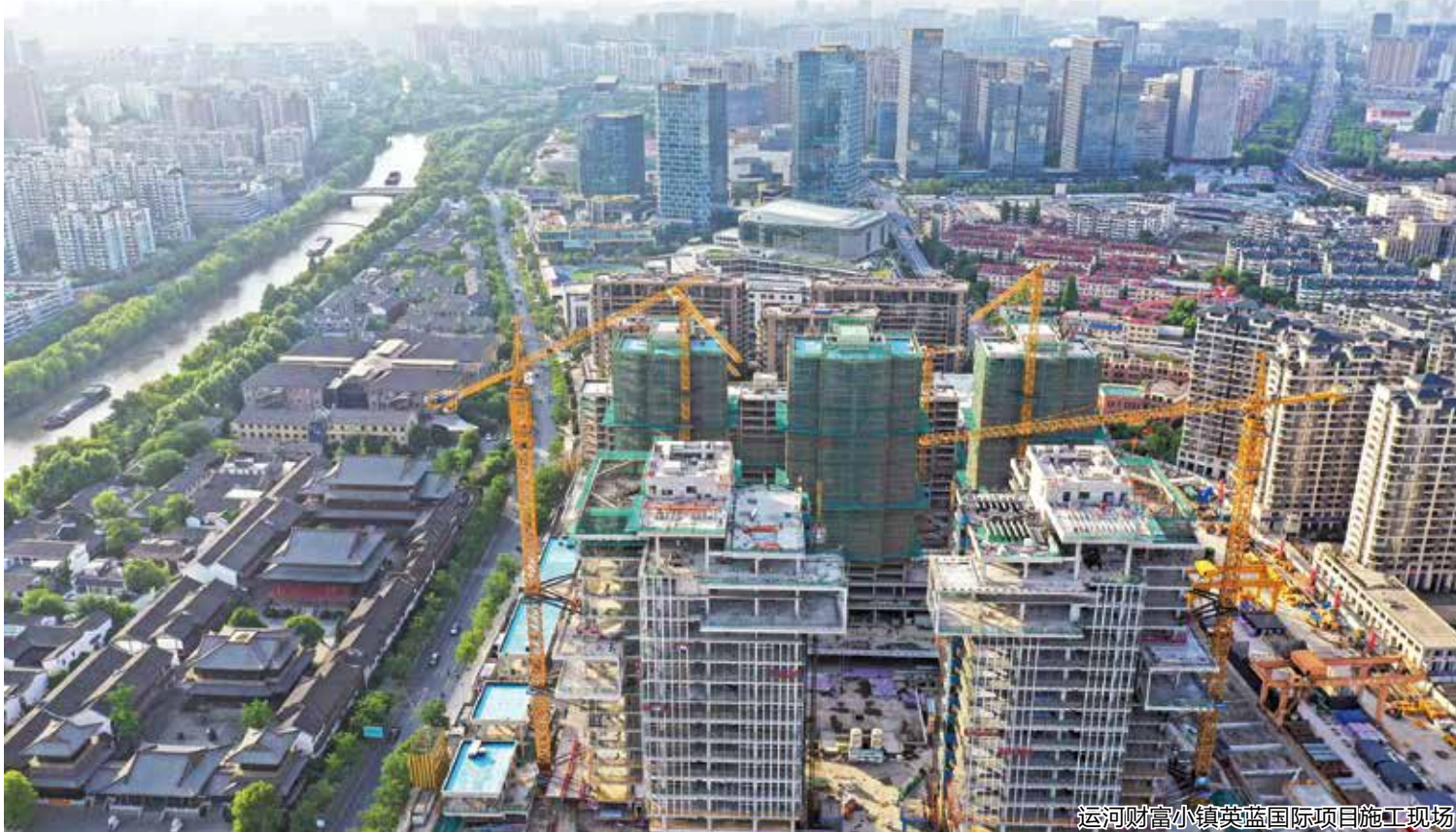
运河财富小镇英蓝国际项目施工现场
