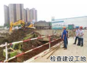
检查建筑工地
