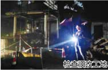
检查旧改工地
