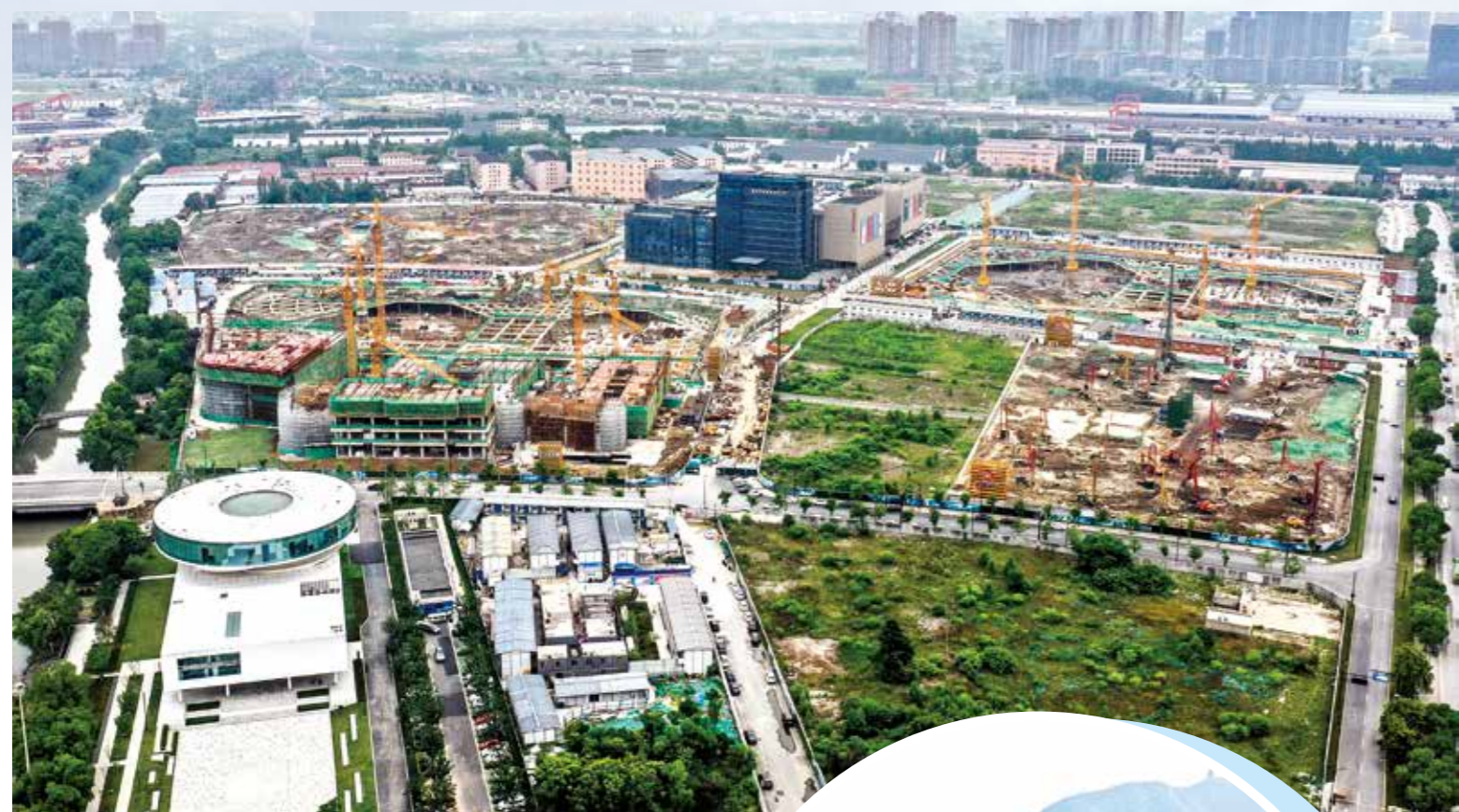
智慧网谷小镇项目建设塔吊林立、热火朝天
