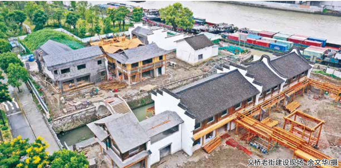
义桥老街建设现场 余文华/摄
