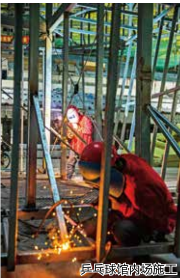
乒乓球馆内场施工
