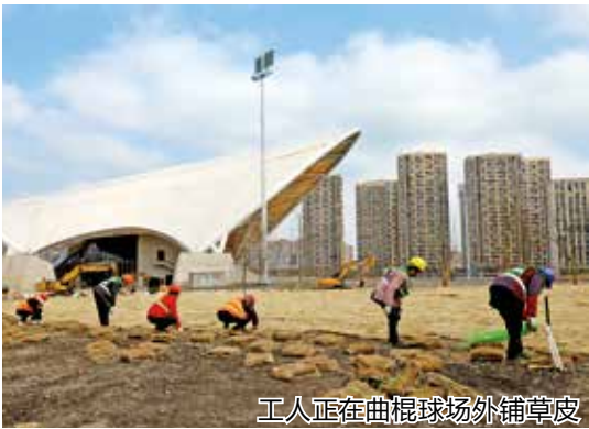
工人正在曲棍球场外铺草皮
