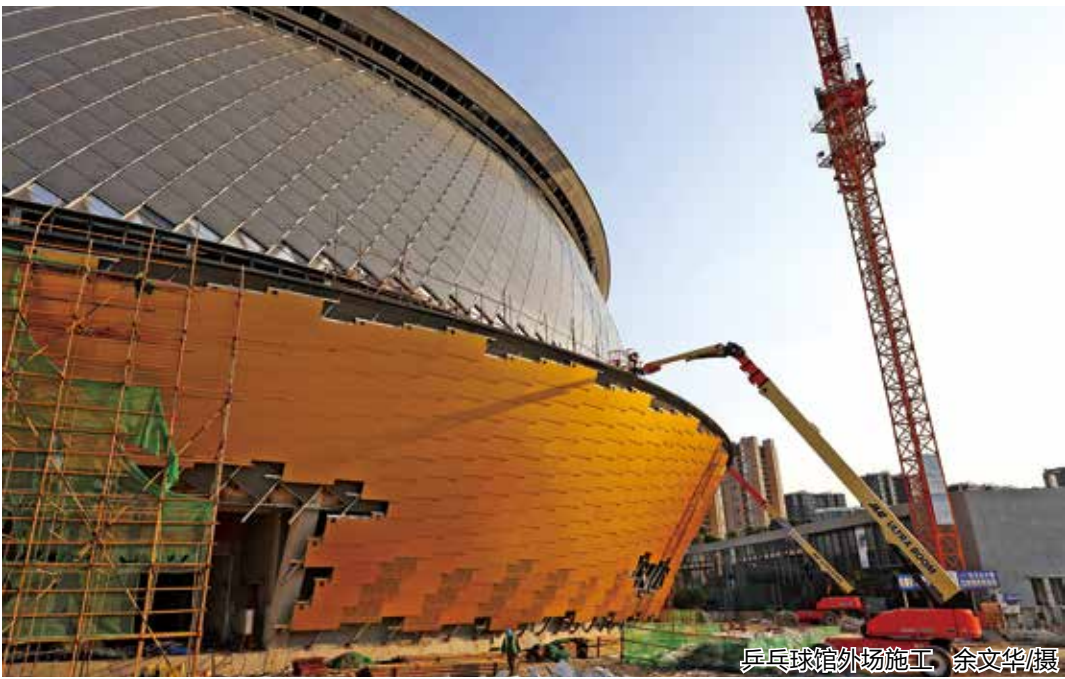
乒乓球馆外场施工 徐文华/摄
