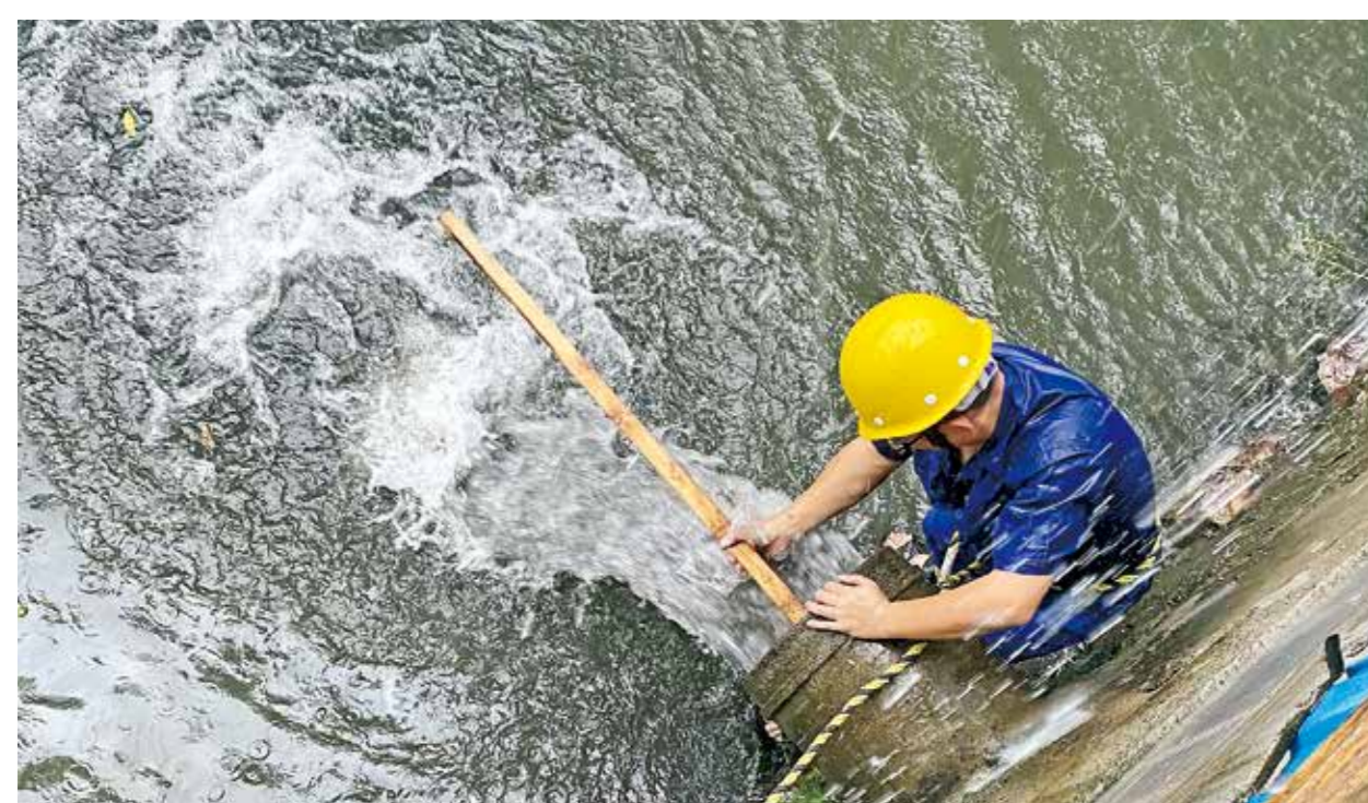
▲暴雨中石桥装饰市场南面通道有明显积水，蒋惠华二话不说绑上安全绳，跳进河里疏通管道。
