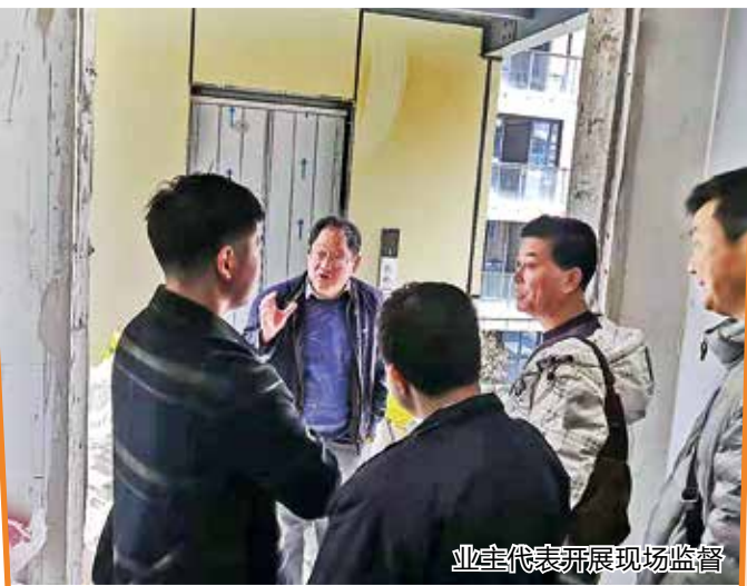
拱墅区首个加装电梯的老旧小区——天时代
