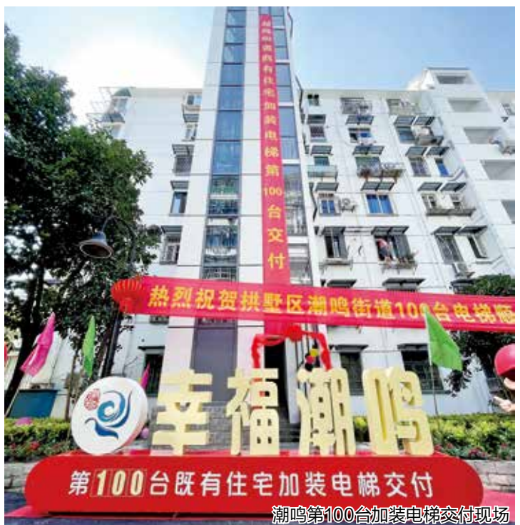
潮鸣第100台加装电梯交付现场
