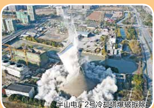
半山电厂2号冷却塔爆破拆除
