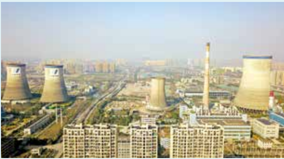
第一次机械拆除后
