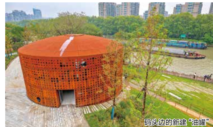
码头边的新建“油罐”
