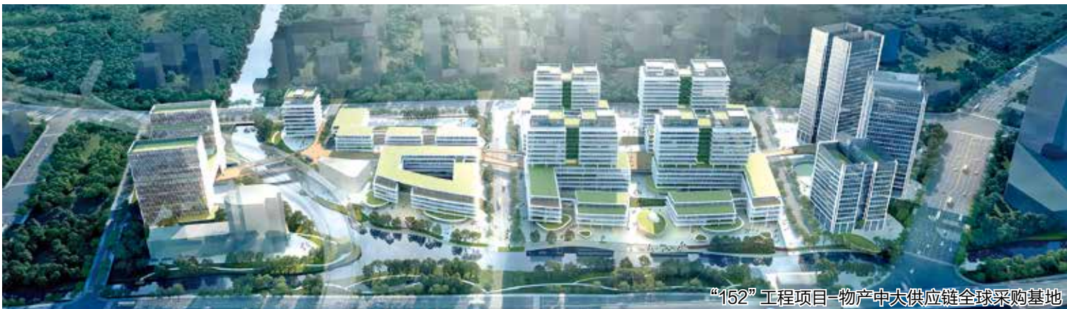
“152”工程项目—物产中大供应链全球采购基地
