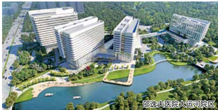
邵逸夫医院大运河院区
