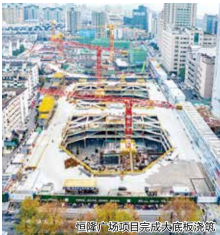
恒隆广场项目完成大底板浇筑
