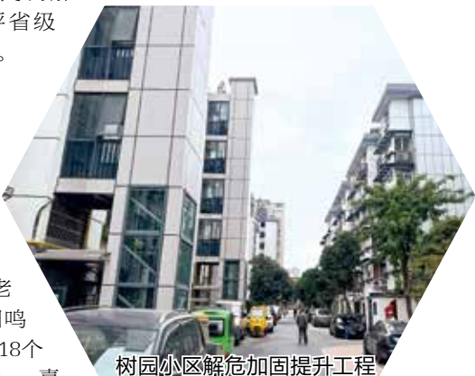
树园小区解危加固提升工程
