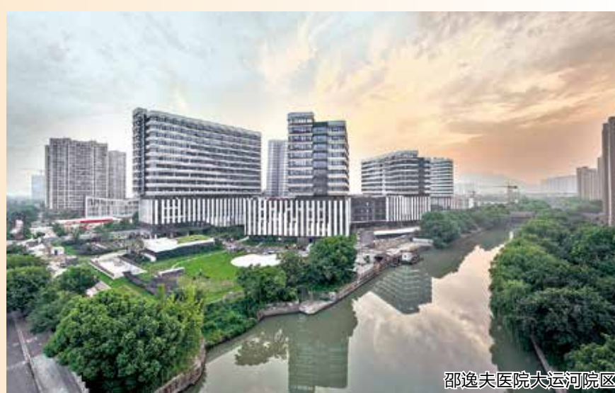
邵逸夫医院大运河院区
