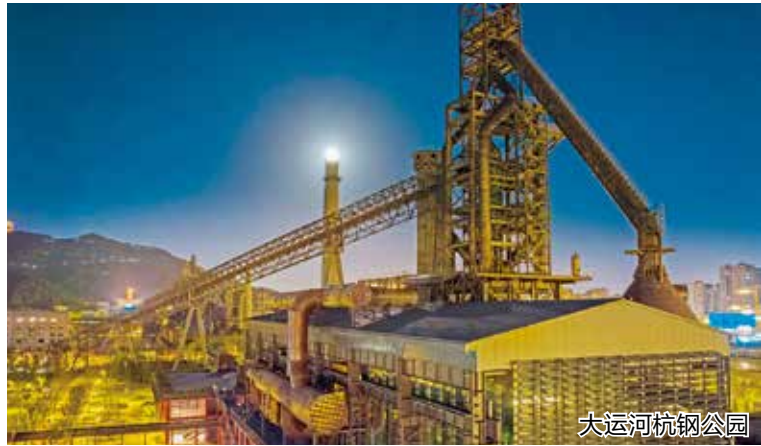
大运河杭钢公园
