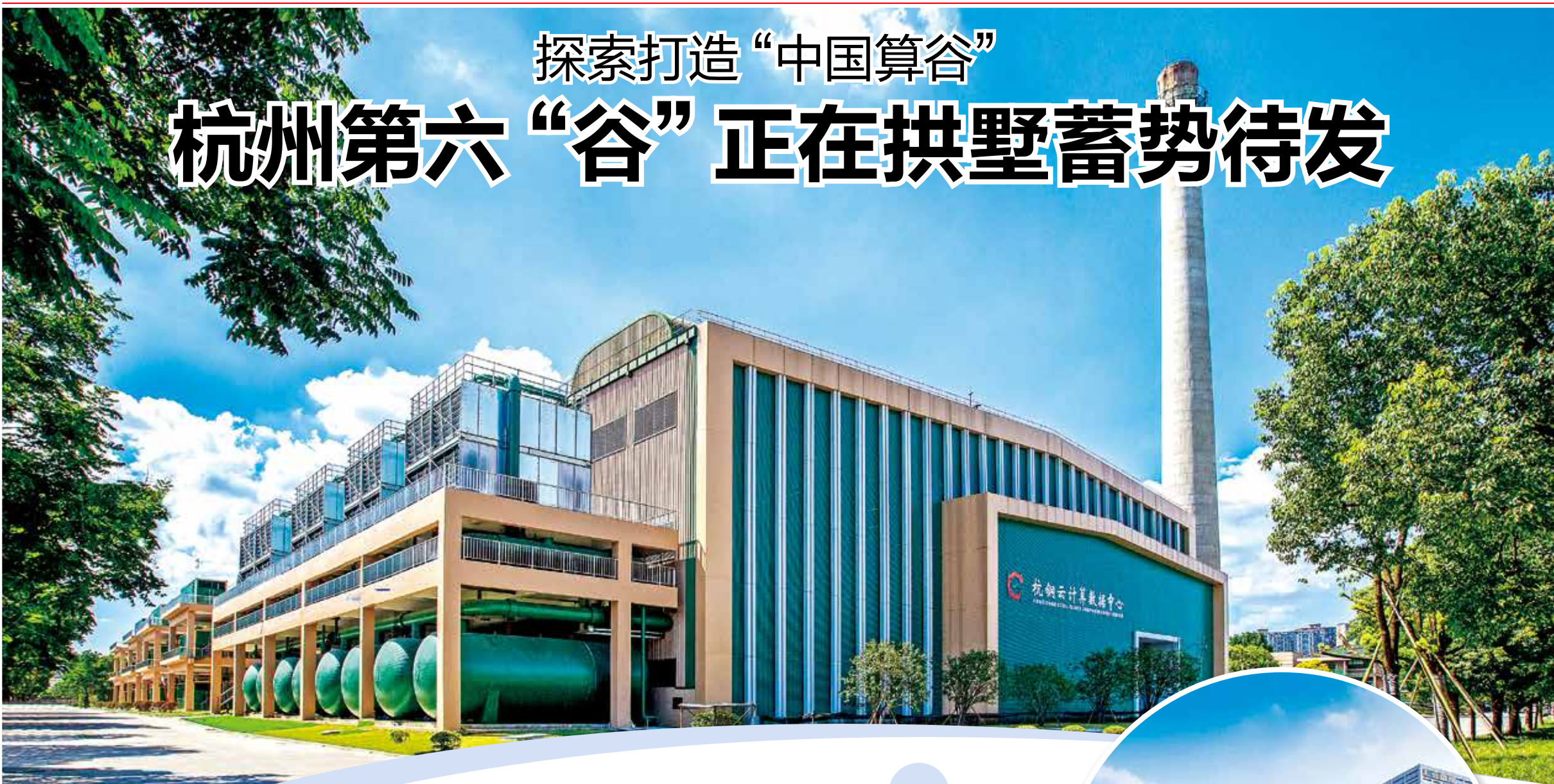
杭钢云计算数据中心
